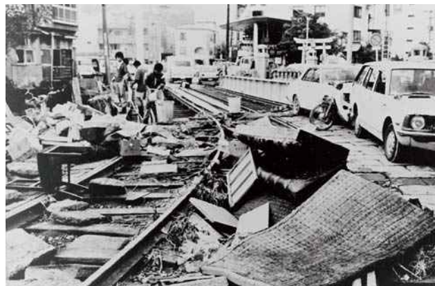
中島川橋梁付近
