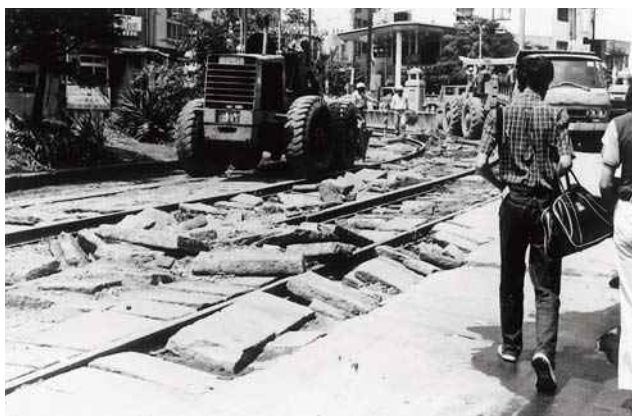
中島川橋梁付近
