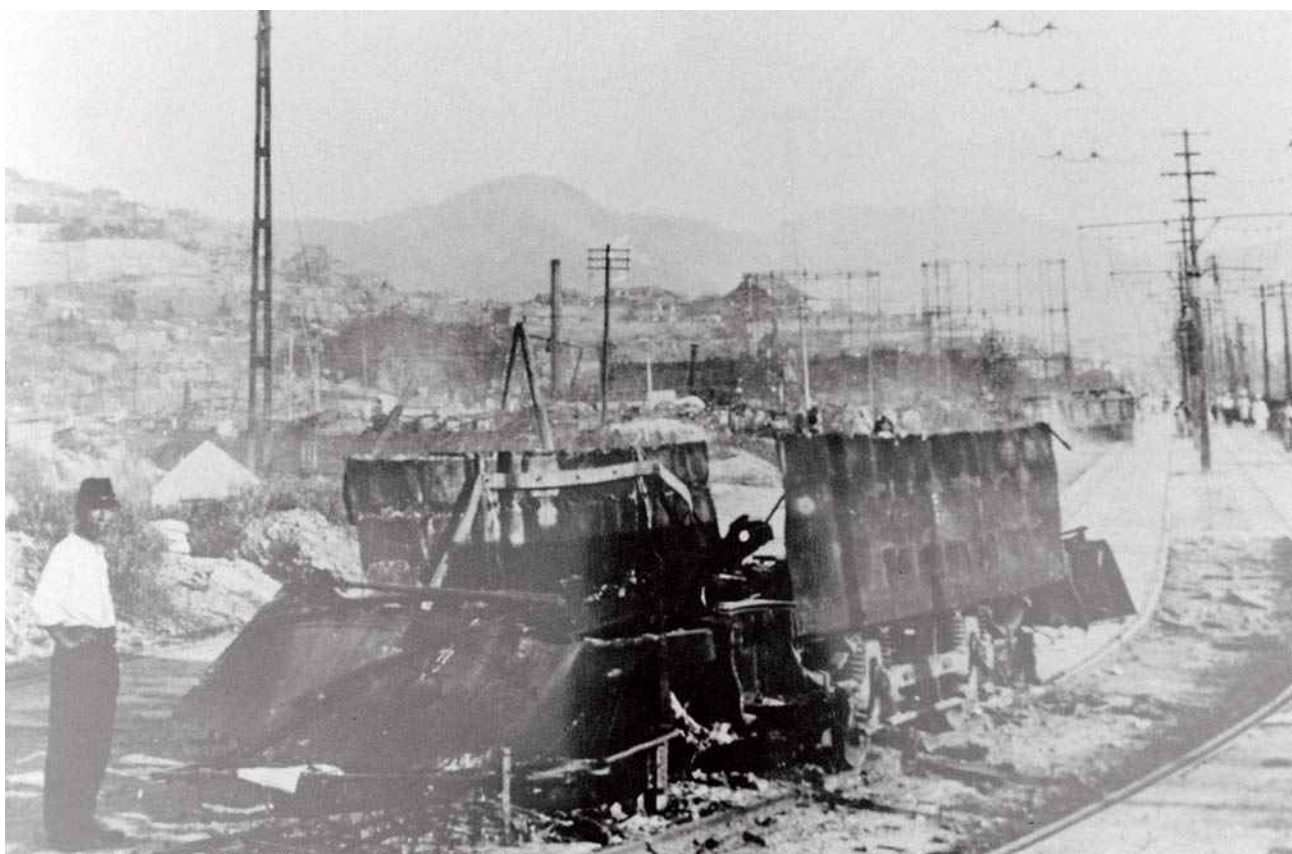
原爆で破壊された電車があった井樋の口
