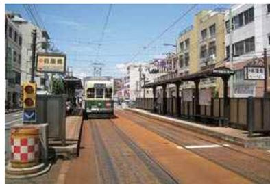
昭和25年9月、住吉延長時に開設した岩屋橋停留場。岩屋川を渡ったところで、この部分から専用軌道と別れ併用軌道となる。開通した時は専用軌道で、住吉に向かって右手が県道で、車道のみ2車線の簡易舗装道路であった。向かって左は一面田畑ばかりで、架空線もシンプルカテナリー方式を採用し
