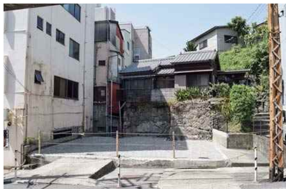
所在地 長崎市天神町 1 - 32 取得日 昭和42年頃 面積 86.61㎡ 用途 天神町変電所跡地
