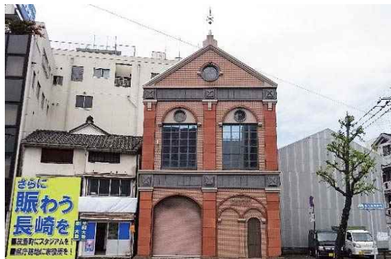
所在地 長崎市賑町 7 - 6 取得日 平成 9 年 2 月 6 日 面積 80.44㎡ 用途 賑町変電所
