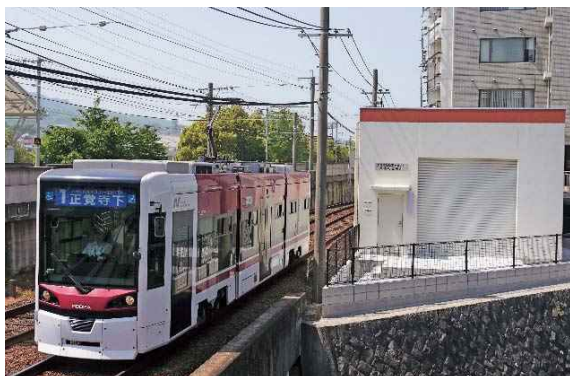
所在地 長崎市松山町 4 取得日 昭和63年 5 月 25日 面積 272.00㎡ 用途 松山町変電所
